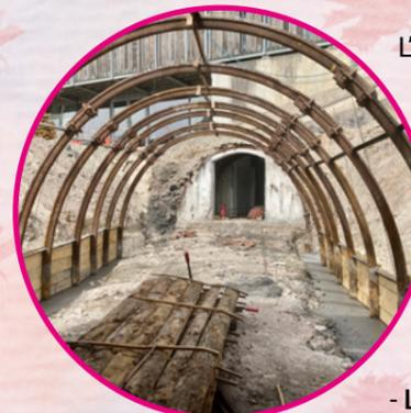
L'ensemble des galeries a été mis à jour et les structures porteuses ont été renforcées. Les entreprises travaillent sur les finitions et la mise en scène intérieure. Pour exemple, les traitements en béton projeté sont achevés, le mur de tir et le mur à l'avant de l'Alpine miner sont réalisés et les monorails sont en cours de montage.
