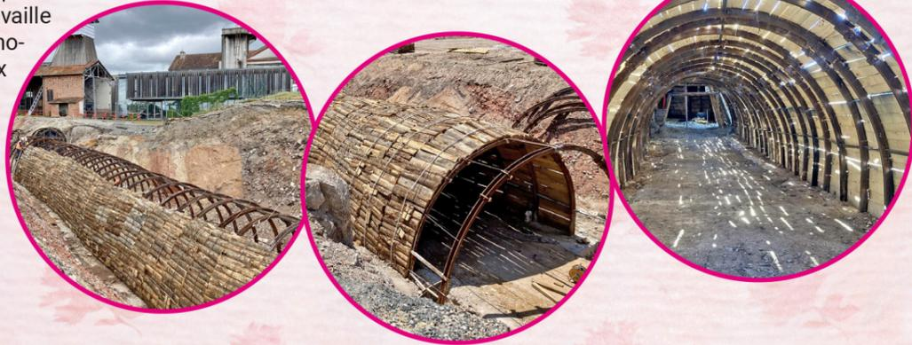
Les charpentiers se sont activés pour réaliser le soutènement. Une partie plus technique et spécifique au boisage réalisé dans les galeries de mine est confiée aux agents du musée, dont un ancien mineur de fond du bassin.
